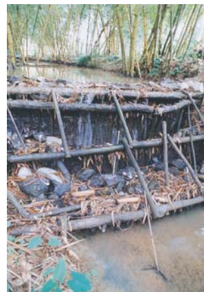
ฟายระลอกความชุ่มชื้น (Check Dam) ๓
